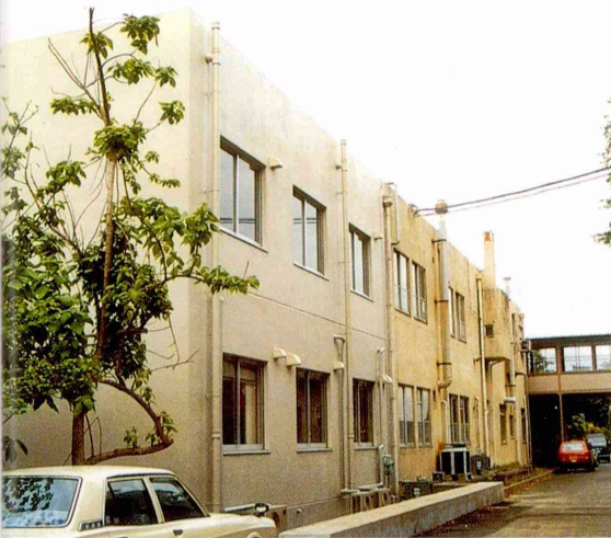
トレーサー棟
