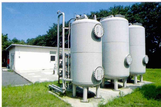
排水処理施設
