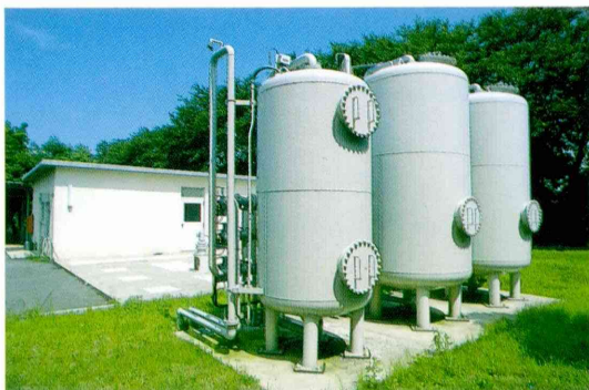
排水処理施設
